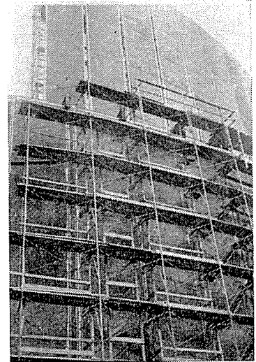
写真-4 外部より見たPCパネルの組み立て
