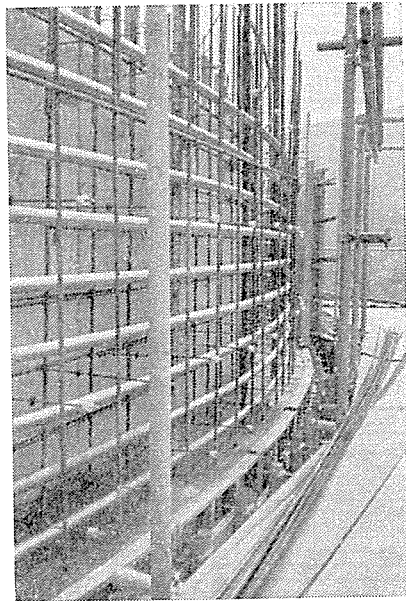
写真-5 鋼線配置
