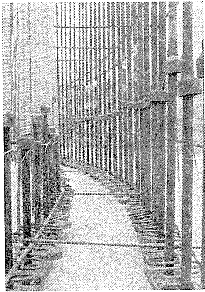
写真-4 鋼棒配置
