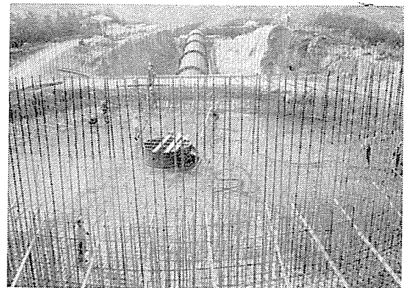
写真-3 底盤の配筋と鋼棒組立
