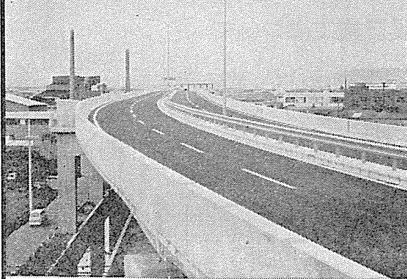
阪神高速道路 / 守口高架橋
