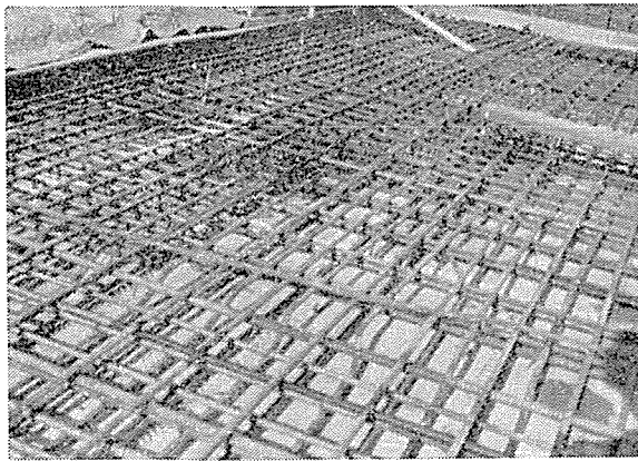
写真-2 鉄筋配置
