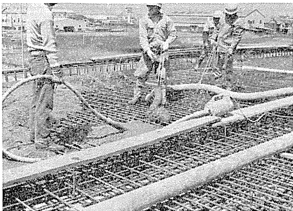
写真-3 コンクリート打設
