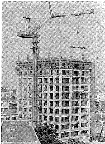
写真-2 建物の施工状況
