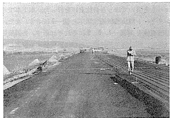
写真-6 各測点 (ctc 10 m) でのアンカー用ブロック (左端)
