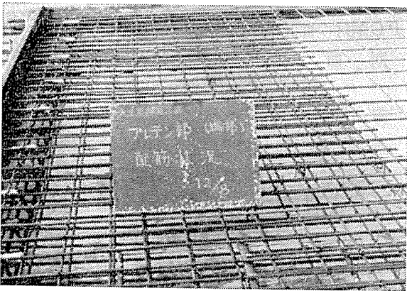
写真-2 膨張目地部補強筋の配筋状況
