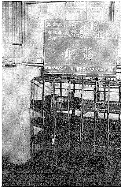
写真-3 プレキャストブロックの接合部
