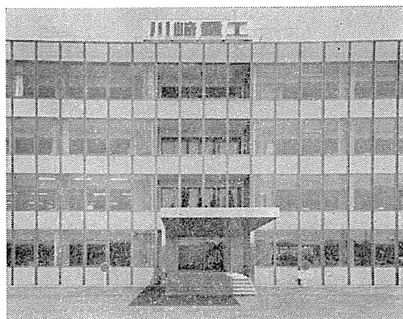
写真-8 川重不動産ビル
