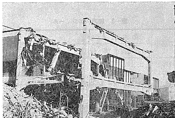
写真-1 試験フレーム
