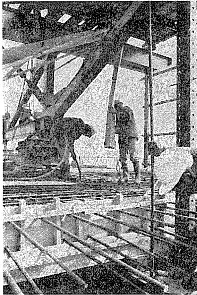
写真-7 ワーゲン部のコンクリート打設
