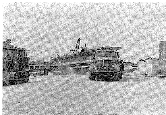
写真—8 トレーラーによる桁運搬
