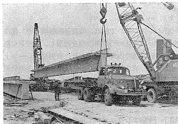
写真—9 トラック クレーンによるトレーラー積込作業
