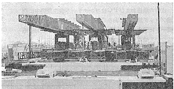
写真-2 移動式吊支保工
