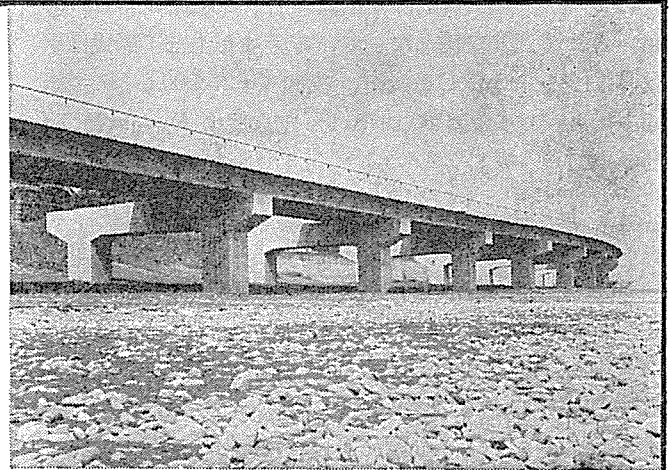
建設省 西湘バイパス道路
