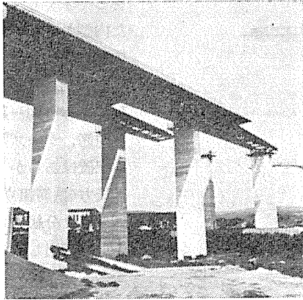
写真一 手延べによる先端部処理
