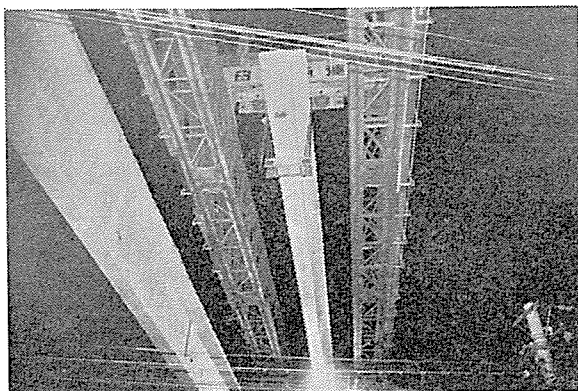
写真-2 西鉄 Bv 主桁架設
