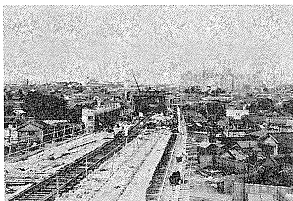
写真-3 板櫃川 B 上に敷設された西鉄 Bv 桁引出し用軌道
