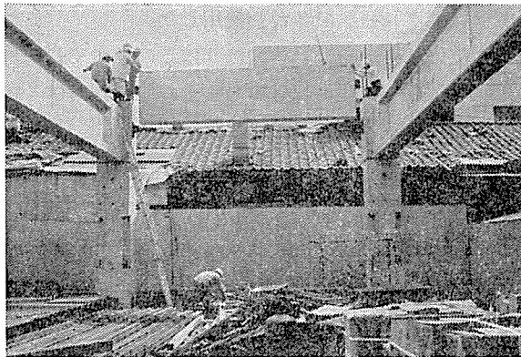
写真-4 桁行ばり架設
