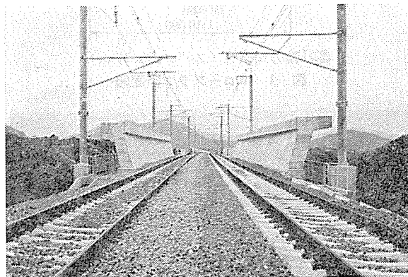
(下路PC桁 スパン 45 m) 写真一1 第2平原架道橋
