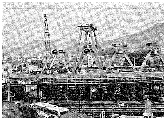
写真-3 斜材, 上格点組立
