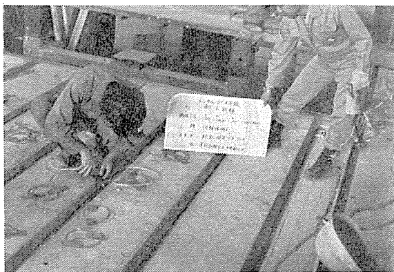
写真-6 大型加熱炉上の組立
