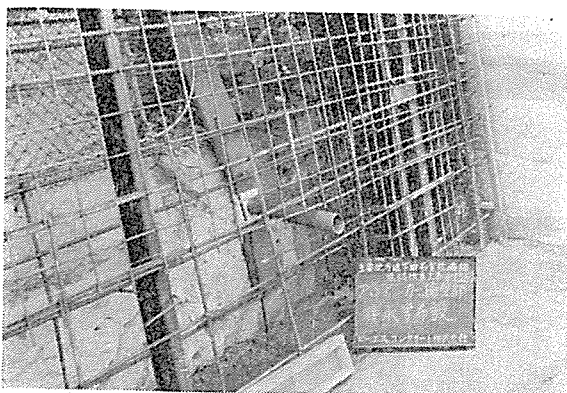
写真-7 コンクリートのり覆工，排水管布設
