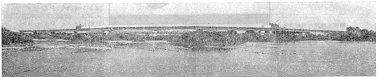
写真-1 東北新幹線名取川橋梁全景
