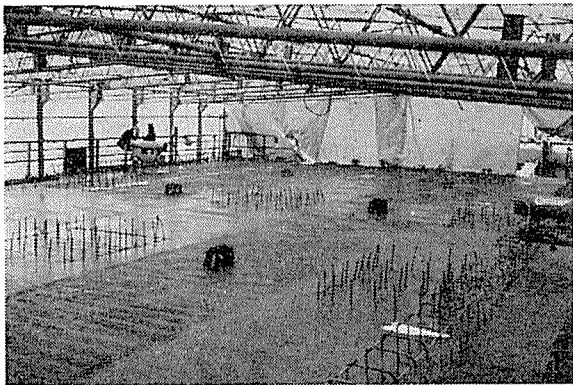
写真-11 冬期養生(ストラバーク)
