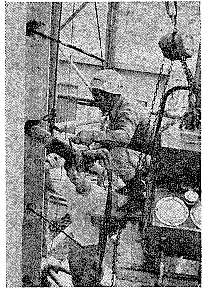
写真-2 緊張作業
