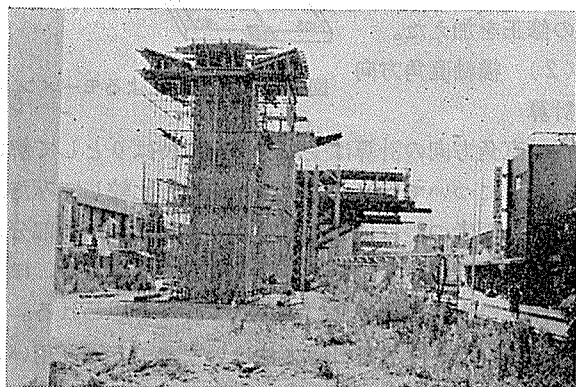
写真-1 受台の施工
