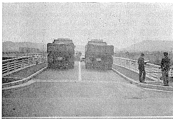
写真-8 載荷荷重用ダンプトラック
