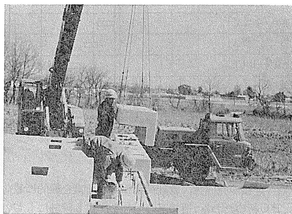
写真-8 地覆ブロックの据付け
