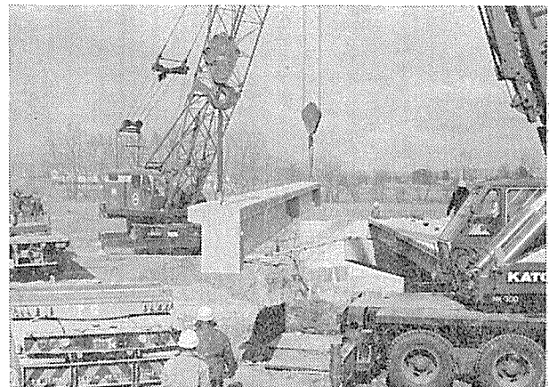
写真—6 PC桁の架設
