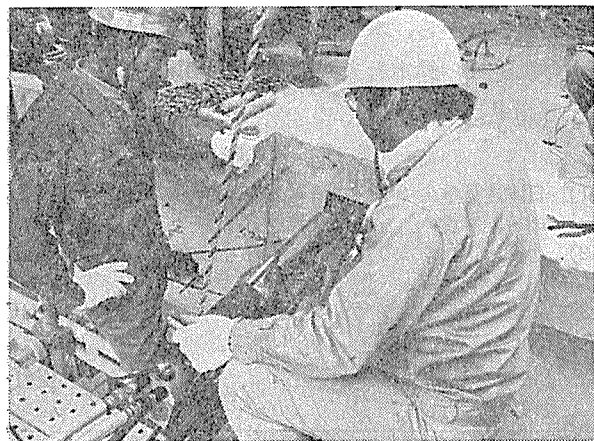
写真一10 プレストレス導入作業
