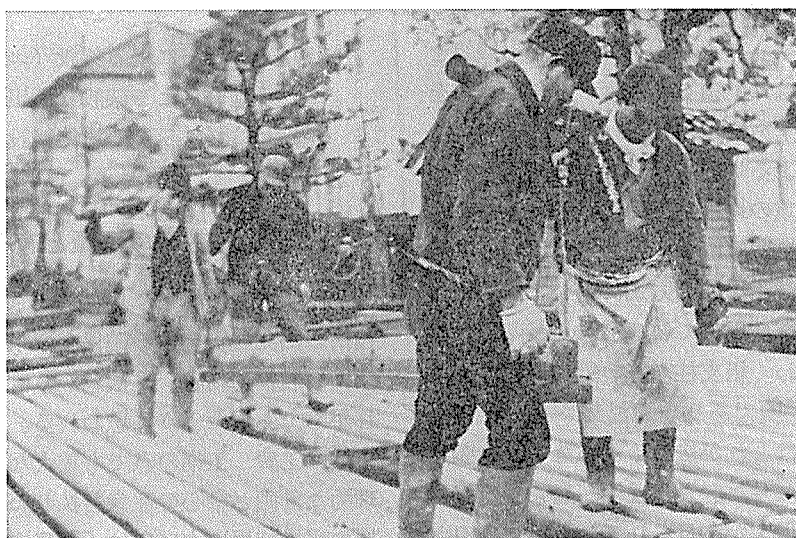
昭和 26 年、日本最初のプレストレスト橋第一号として、石川県七尾市内の御抜川に架設された長生橋（プレテンション桁）は、人力によって架設された最も初歩的なものである。
