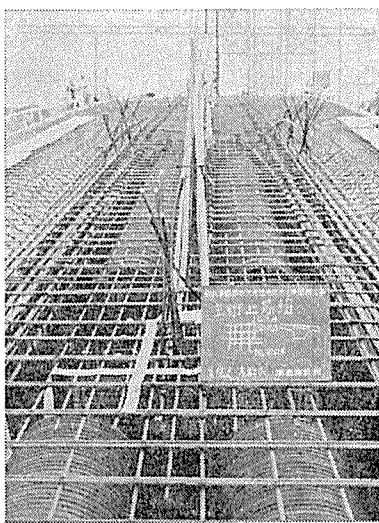
写真-2 主桁 PC 鋼棒および鉄筋の配置
