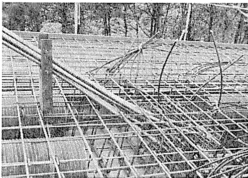
写真-1 斜材 PC 鋼棒主桁埋込み部
