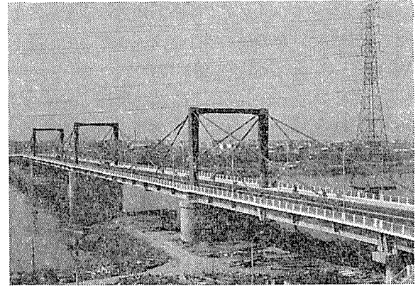
写真-1 完成写真
