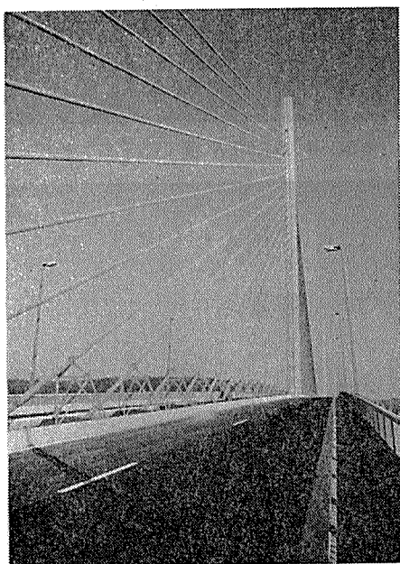
写真-2 Brotonne 橋 歩道上より
