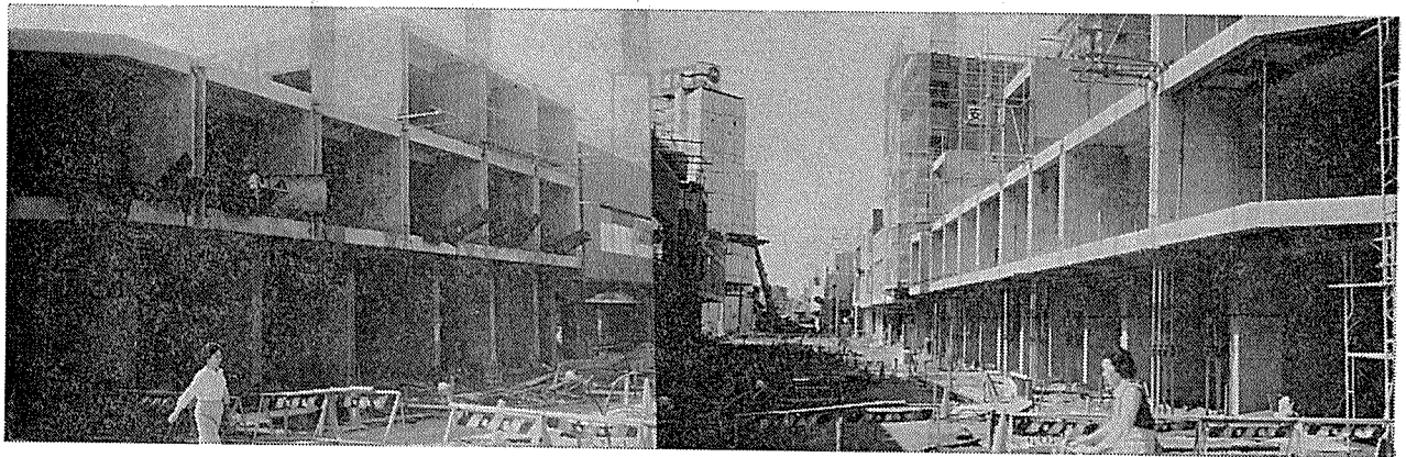
写真-7 9,10 街区 PC 組立て完了
