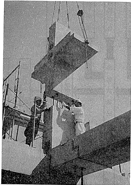
写真-5 十字部材の組立て
