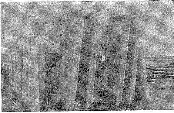
写真-7 カーテンウォールのストック
