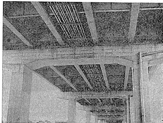
写真-3 首都高速道路公団 高速3号線
