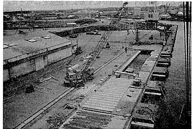
写真-3 桁据付け状況
