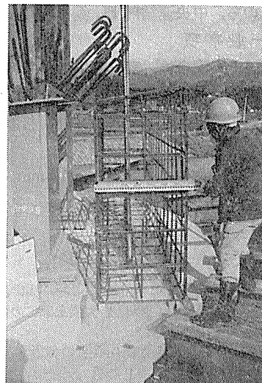
写真—16 仮沓配筋および PC 鋼材配置状況
