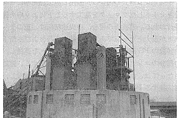
写真—17 仮固定部 H 形鋼配置状況
