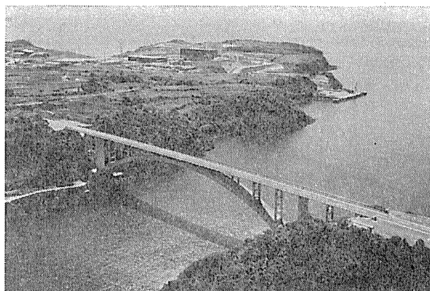
写真-1 外津橋全景
