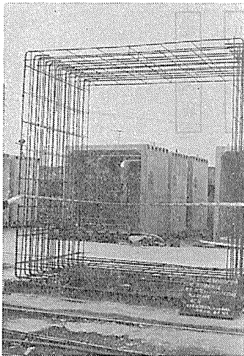
写真—2 PSC ボックスカルバートと鉄筋組立て仕様 (部分プレストレスト)
