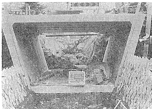
写真—11 排水路横断簡易道路橋
