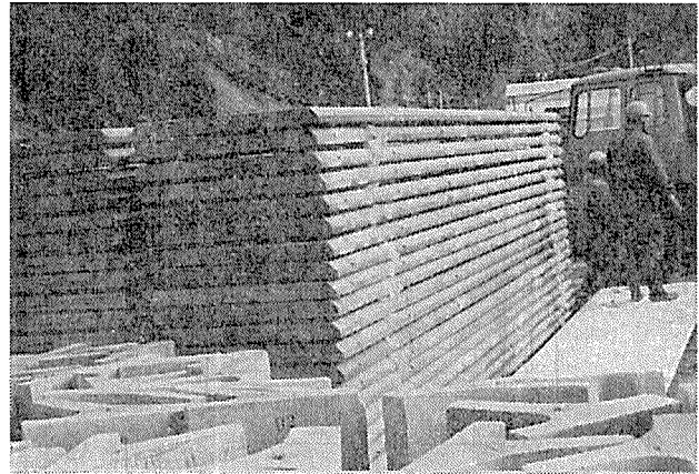
写真-1 現場に搬入された PC 天井版および受台
