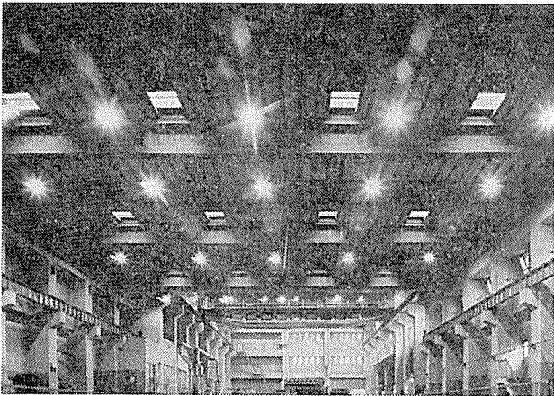
写真—5 ポンプ室の屋根版に使用したダブル T スラブ
