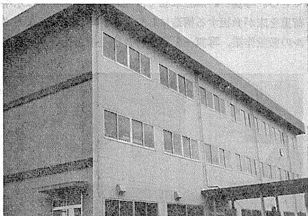
写真—5 学校建築の外壁
