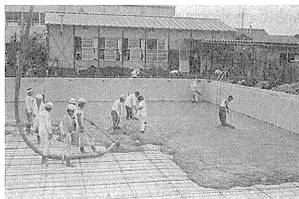
写真一5 底版コンクリート打設
