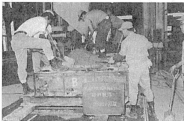
写真一2 側版の製作
