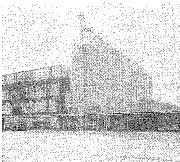
写真-1 完成した PC サイロ
