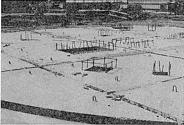
写真-4 製作ヤード上の屋根 RC プレキャスト床版
