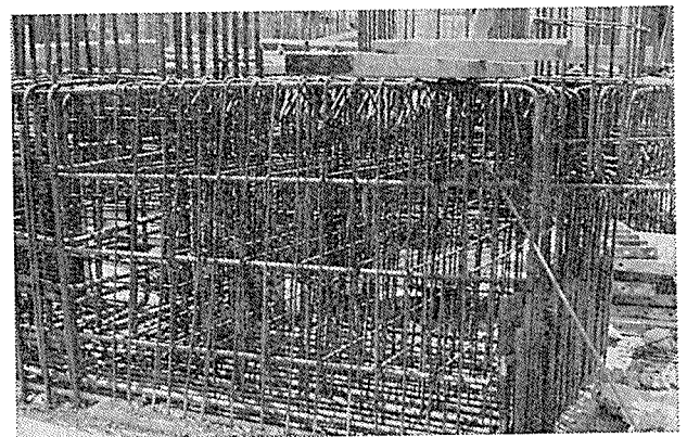
写真-2 地中梁のスターラップ
