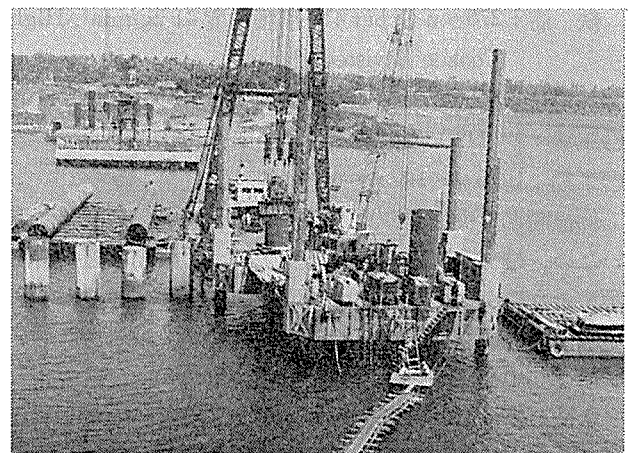
写真-5 基礎工全景
