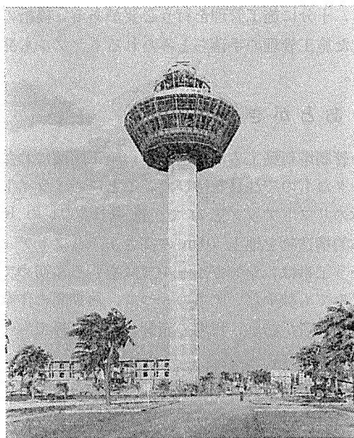
写真—6 リフトアップ完了
