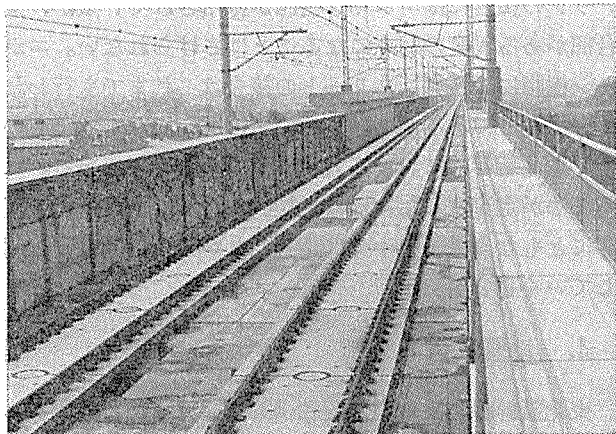
写真—3 東北新幹線に使用されている PC スラブ軌道
