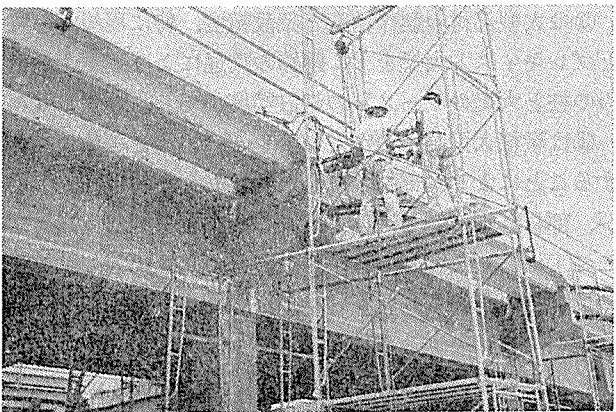
写真—11 屋上階大梁と小梁、はね出し梁の緊張接合
