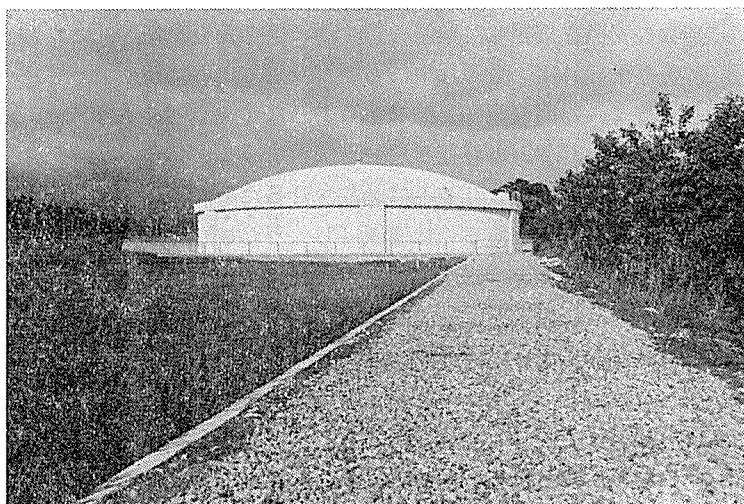
写真一1 富山市の配水池
