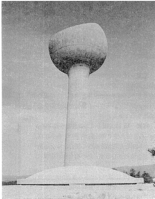
写真一16 瀬戸市にある配水池
