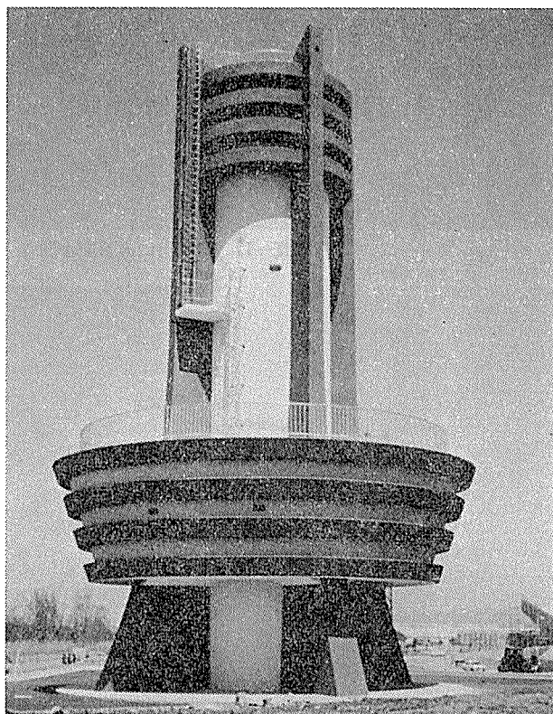
写真-14 松本市にある配水池
