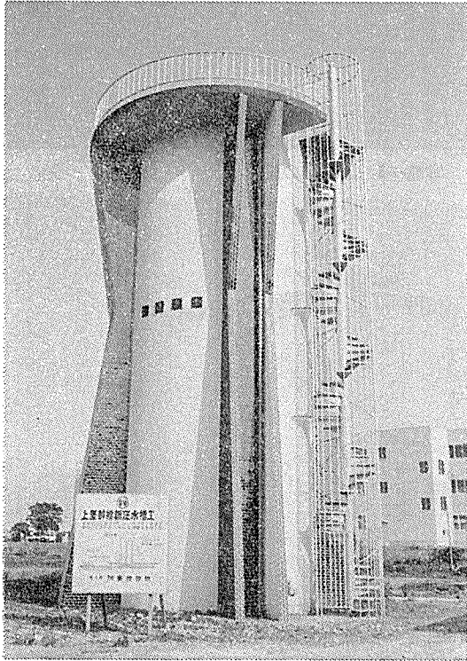
写真-7 埼玉県内にあるサージタンク
