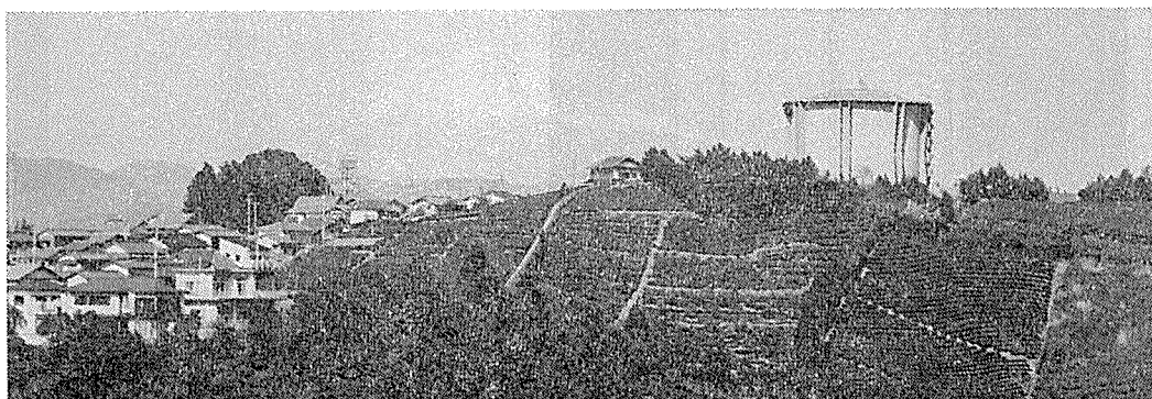
写真—6 清水市にある配水池
