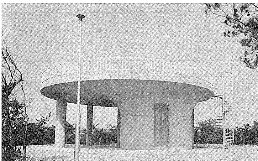
写真—20 愛知県内にある配水池
