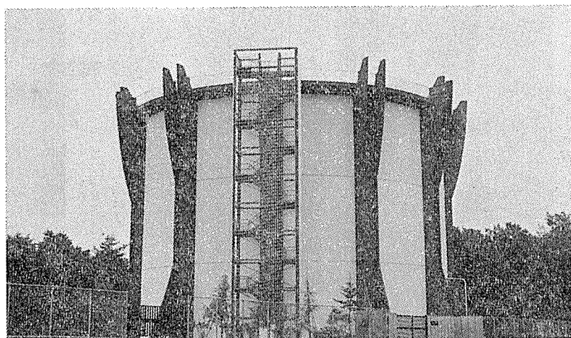
写真—4 水沢市の配水池
