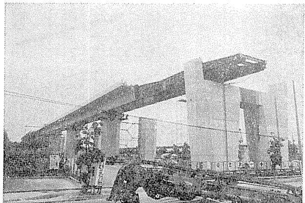
写真-5 押し出し作業状況
