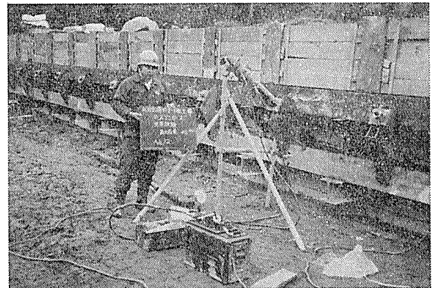
写真-2 SEE 工法における引張試験
